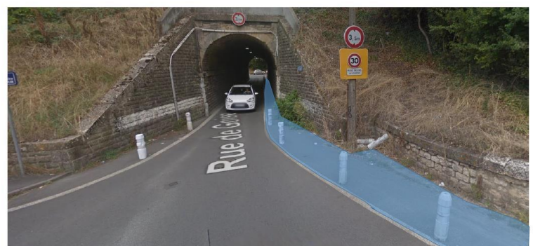
Localisation du trottoir sous le pont SNCF
