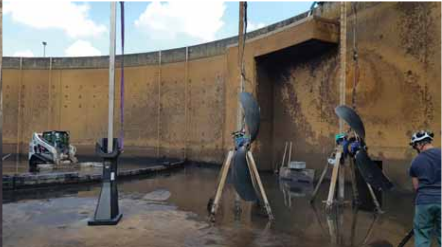
Renouvellement diffuseurs fines bulles bassin bio, remplacement d'un propulseur (installation de la « chaise ») - STEP Goilard (Niort)
