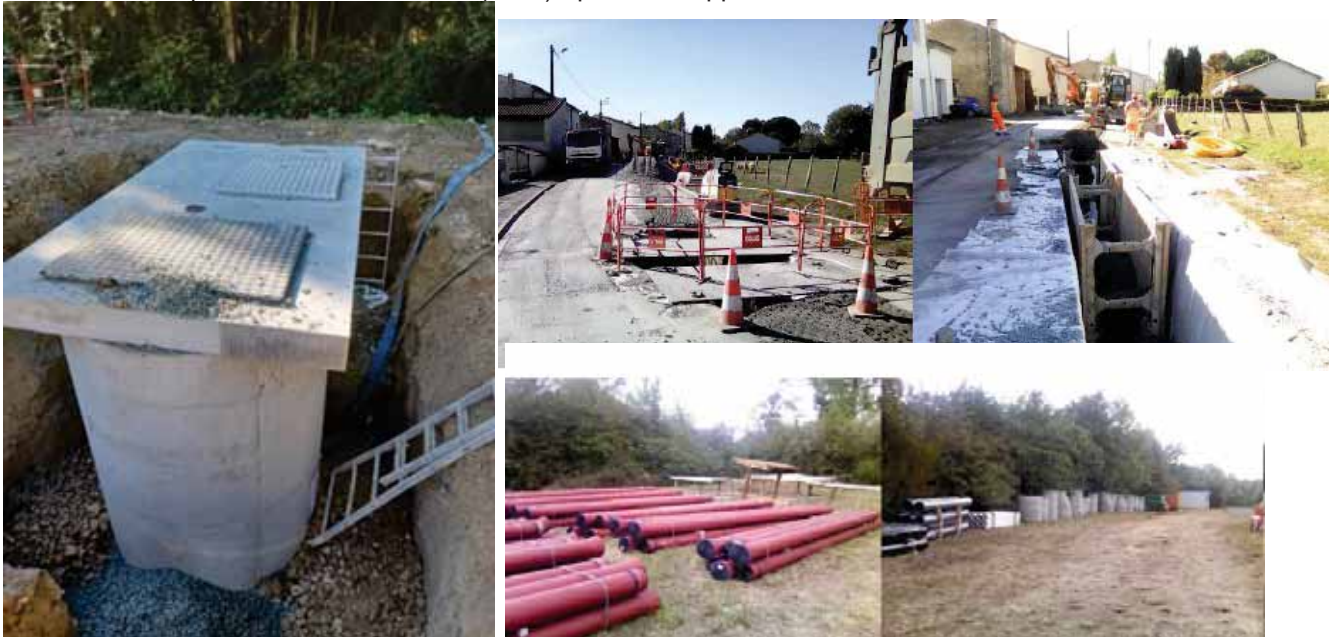
Pose du poste de refoulement de la Tranchée (Niort)
