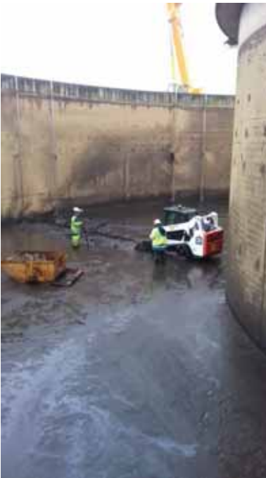
Renouvellement diffuseurs fines bulles bassin bio, remplacement d'un propulseur (installation de la « chaise ») - STEP Goilard (Niort)
