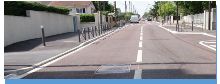
Voirie et espaces publics
